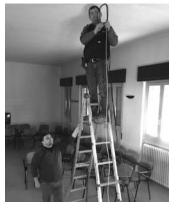
TECNICI AL LAVORO
